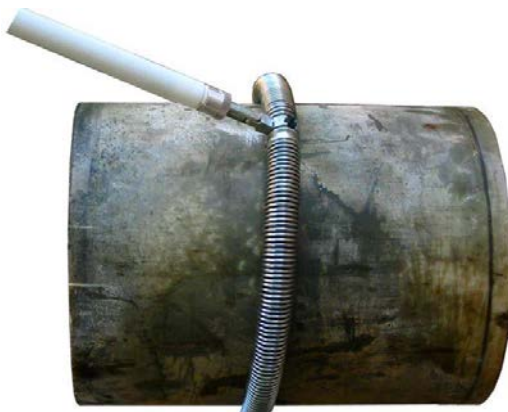
Рис. 26. Подготовленный к проведению контроля пружинный электрод с подсоединенными захватом и удлинителем
